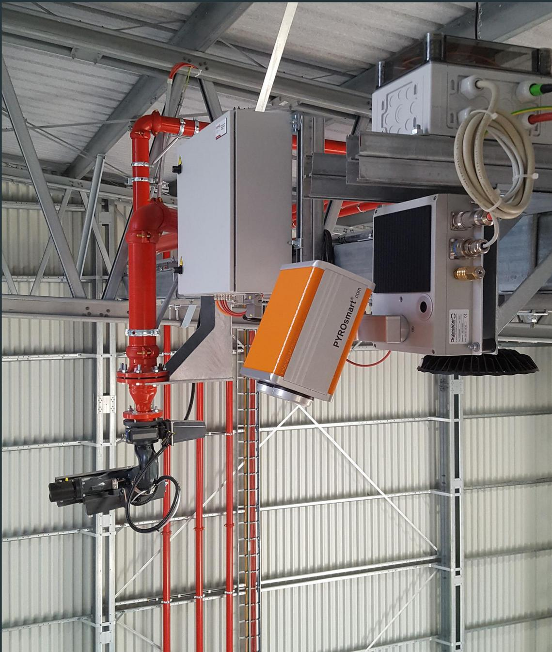
Eine thermografische Analyse des Überwachungsbereiches im Zusammenspiel mit einer automatisierten und zielgenauen Löschung, verhindert Brände (vor deren Entstehung) und stellt den aktuellen **Stand der Technik** dar!
