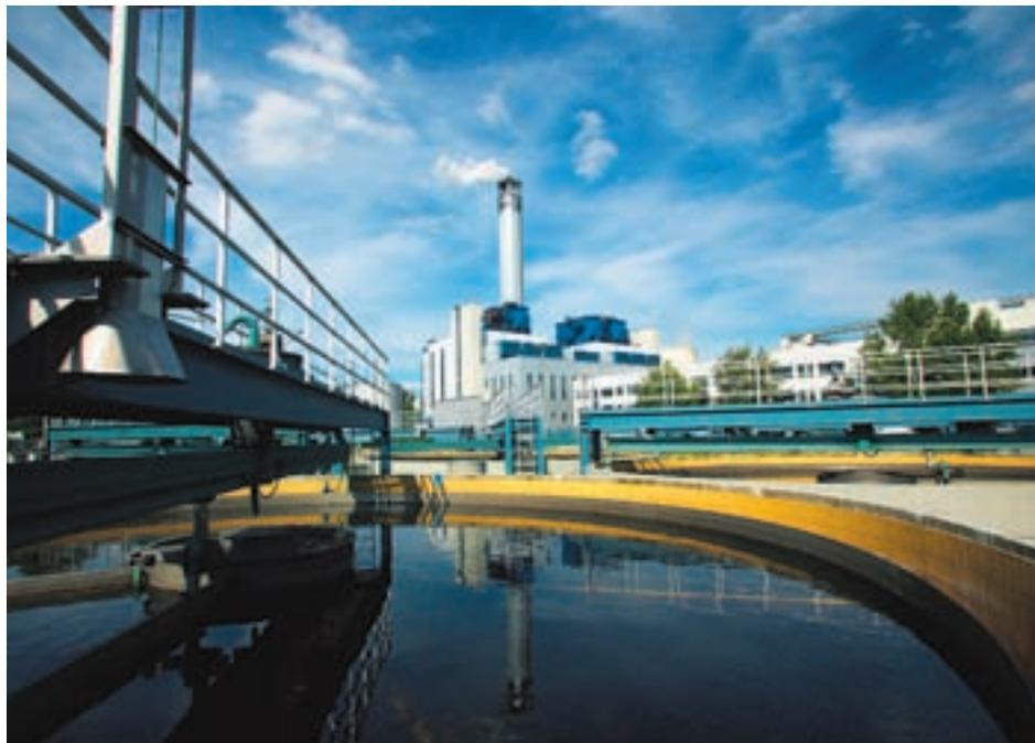
Hier wird Schmutzwasser wieder rein: Nachklärbecken in der Kläranlage Ruhleben. Im Hintergrund das „Klärschlamm-Kraftwerk“, in dem der Schlamm in Energie verwandelt wird.
