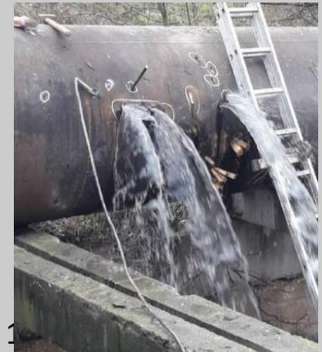
6. Der Abschnitt des drucklosen Sammlers in über die Tschernomorsker Straße von der Aivazovsky Straße bis Kanlpumpstation-1 muss aufgrund seines unbefriedigenden technischen Zustands dringend ersetzt werden. Die Sanierung wird Notfallsituationen durch den Zusammenbruch des Gewölbes im Notfallsammler und die Einstellung der Entwässerung von anliegenden Häusern verhindern.
