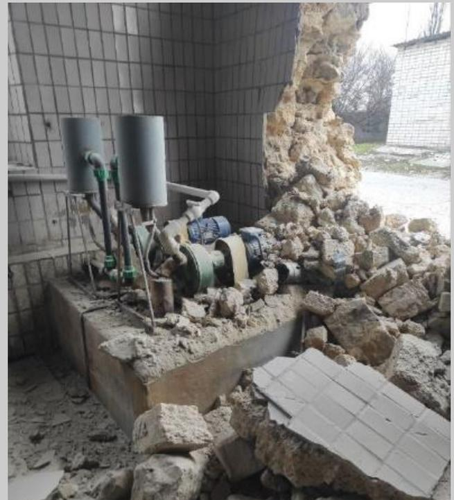
8. Technische Umrüstung der Wasserpumpstation-1. Die Rakete traf den Maschinenraum und zerstörte die Pumpeneinrichtung. Die Pumpstation versorgt die Bewohner des zentralen Teils der Stadt mit Wasser und muss wiederaufgebaut werden.
