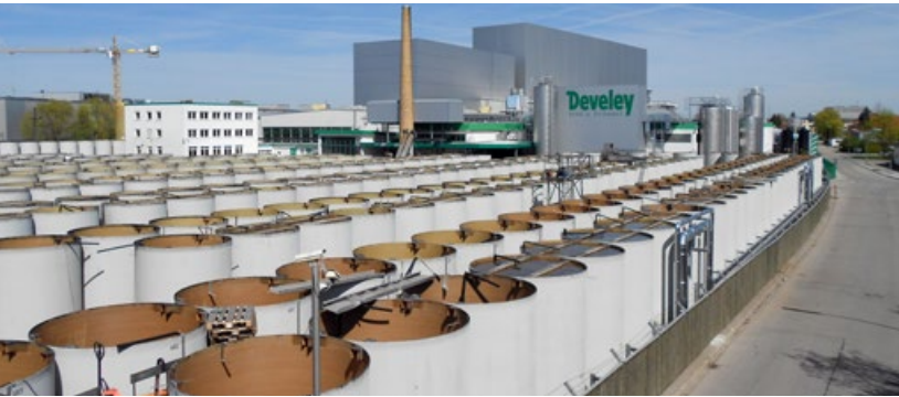
Develey-Werk im niederbayrischen Dingolfing
