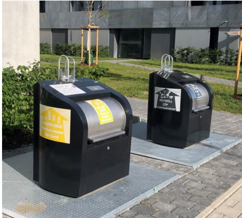
Unterflurpresscontainer für LVP und Restabfall, Ingolstadt, Quelle: Sidcon
