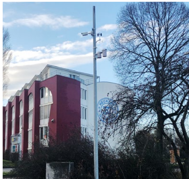
Glättemeldeanlagen, Quelle (beide Bilder): TDL
