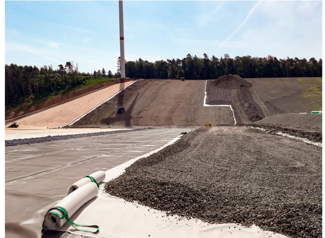
Abb. 5.3: Dichtungsbau zur Erweiterung der Deponie Kapitaltal (DEUBIG et al. 2021)
