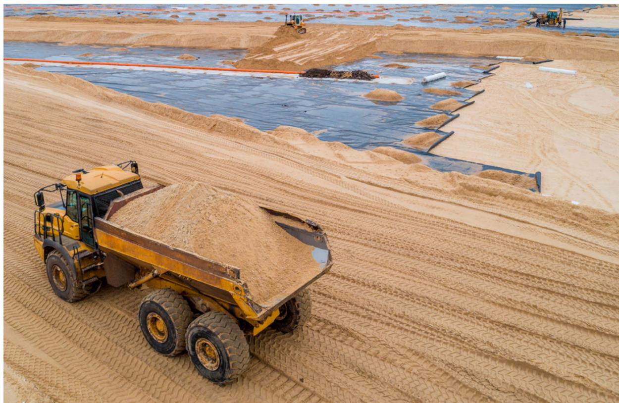
Der Bau einer Deponie und die Verlegung der Dichtungsbahnen
