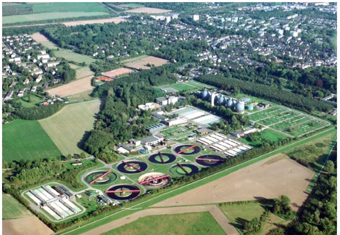
Großklärwerk (GWK) Köln-Stammheim und naheliegende Siedlung
