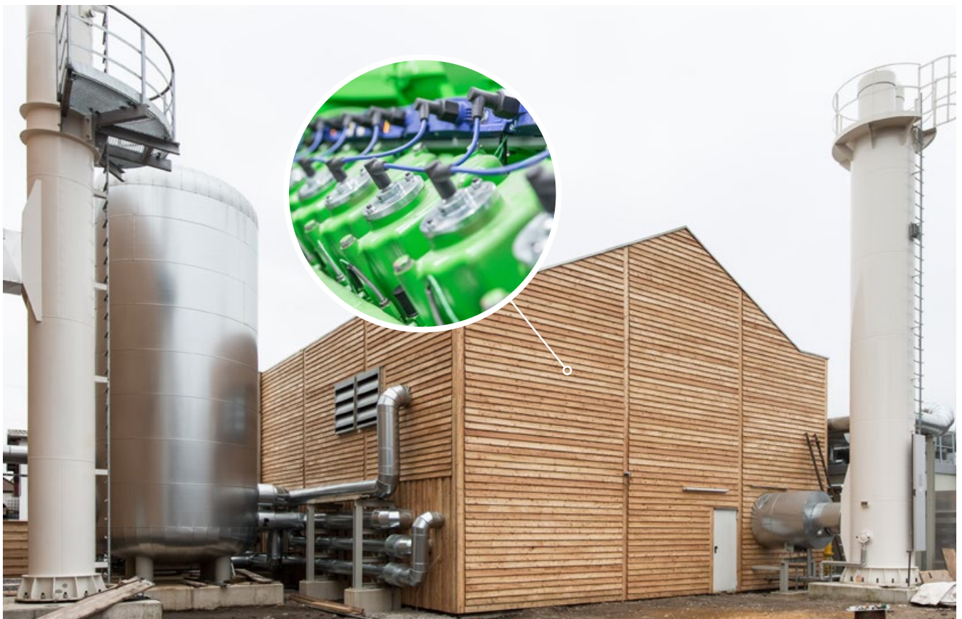
Biomasse-Heizkraftwerk Hungerkamp in Braunschweig
