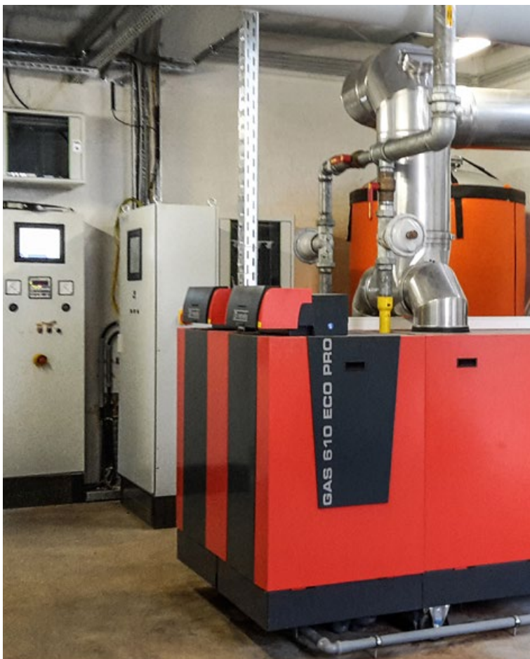
Spitzenlastkessel (links) und Wärmeverteiler (rechts)
