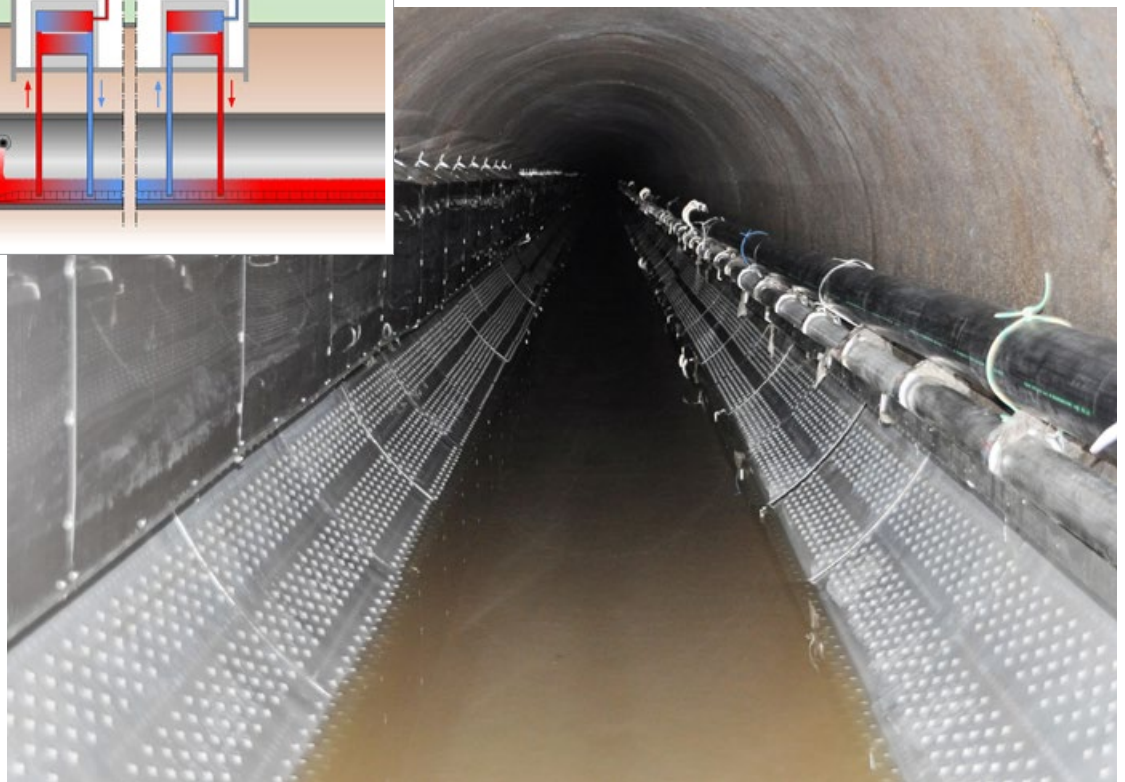
Funktionsprinzip (links) Wärmetauscher im Abwasserkanal (rechts)
