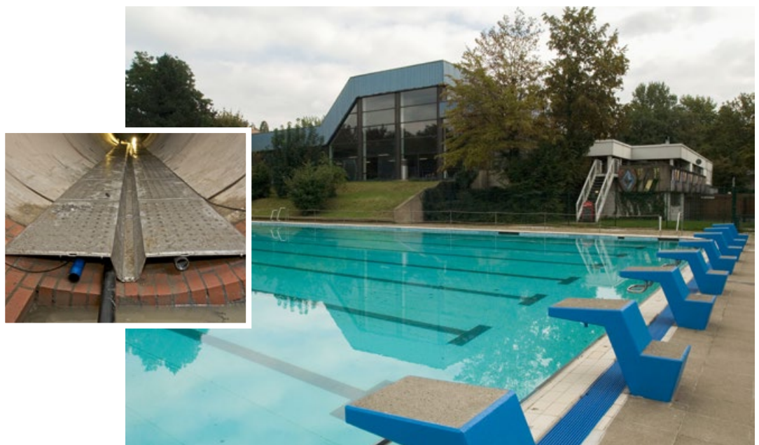
Wärmetauscher im neugebauten Abwasserkanal (links) Nordwestbad Bochum (rechts)
