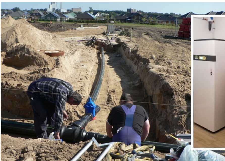
Verlegung Erdkollektor im Baugebiet Berender Redder (links) Wärmepumpenheizungsanlage beim Kunden (rechts)
