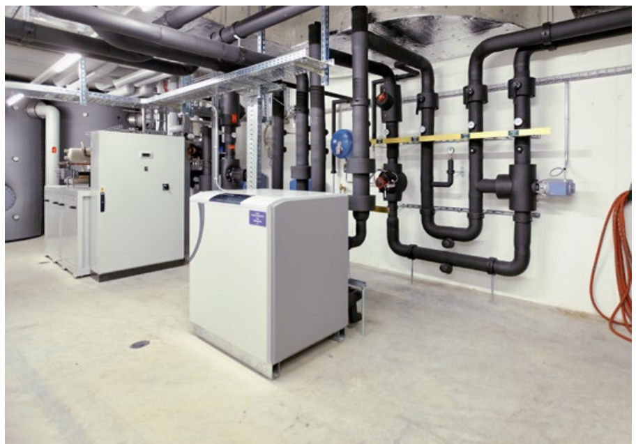
Pelletheizungsanlage
