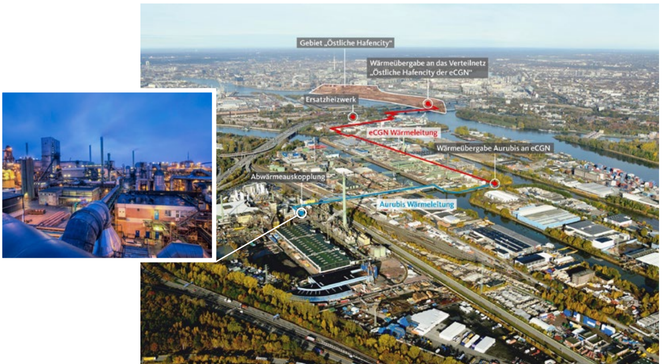
Kontakanlage (links) Fernwärmetrasse (rechts)
