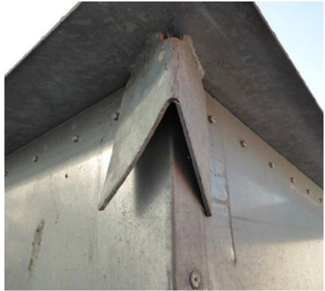
Abbildung 37: Führungsecken; Quelle: AWB Köln GmbH
