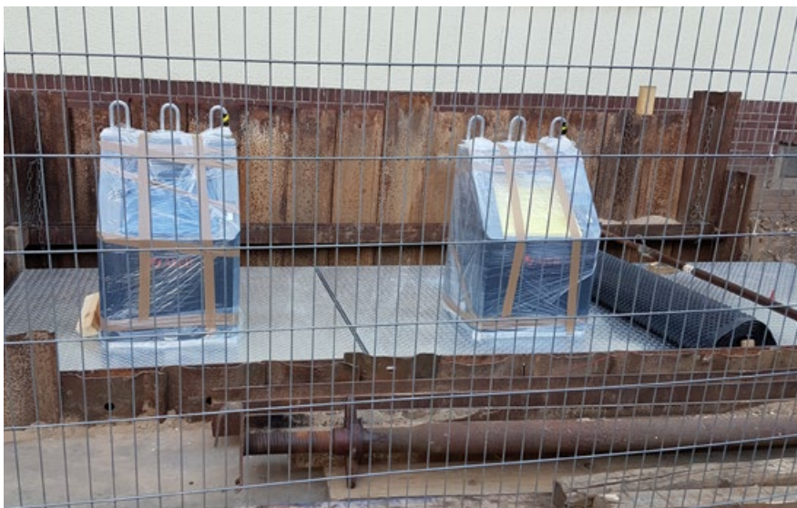
Abbildung 17: Einbau eines Unterflursystems; Quelle: AWB Köln GmbH
