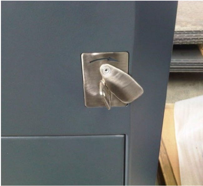
Abbildung 36: Schließsystem; Quelle: AWB Köln GmbH
