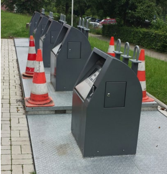
Abbildung 30: Aufgetriebene Betonwannen; Quelle: HEB Hagen
