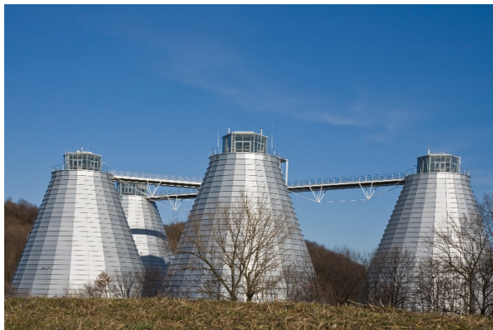
Faultürme für das Klärwerk der Stadtentwässerung München
