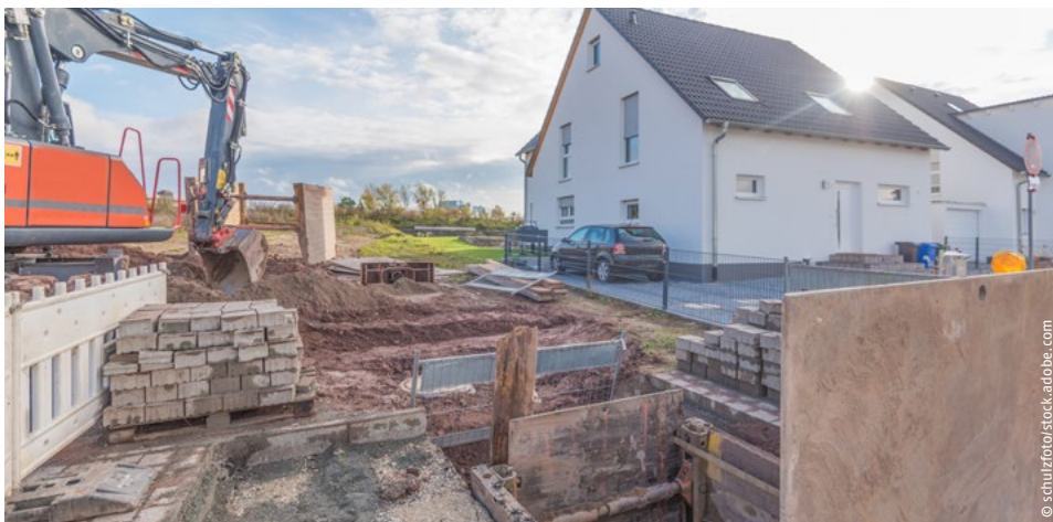
Die Hauptanschlussleitung ist unentbehrlich für spätere Wasserlieferung.
