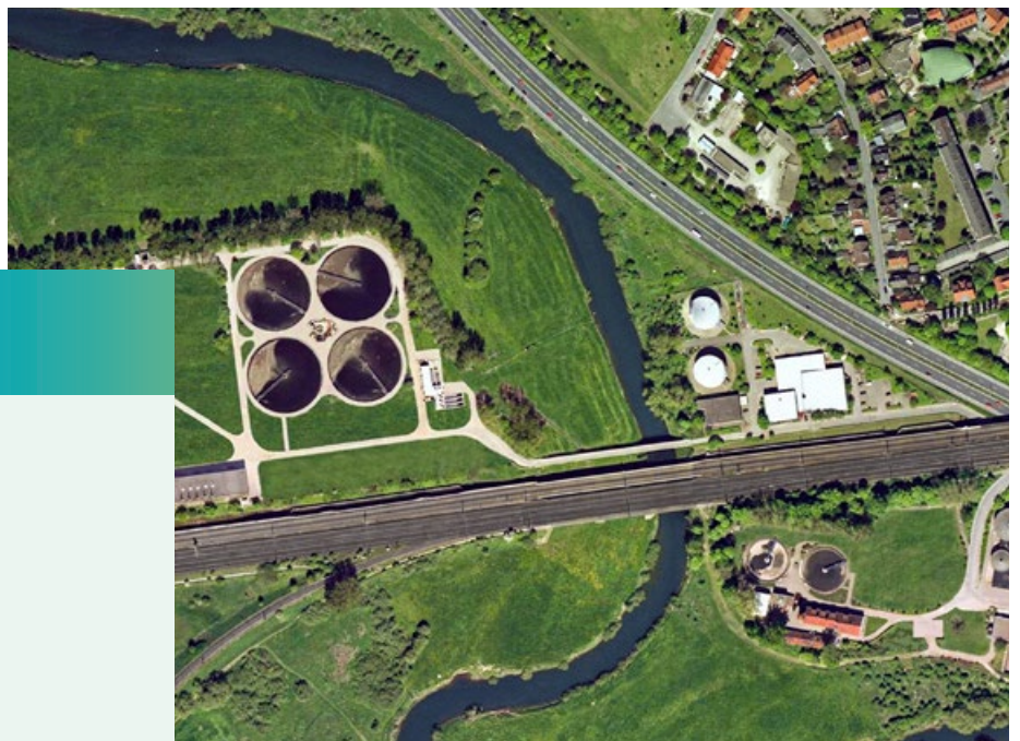
Luftbild Klärwerk Hannover-Herrenhausen Quelle: Stadtentwässerung Hannover
